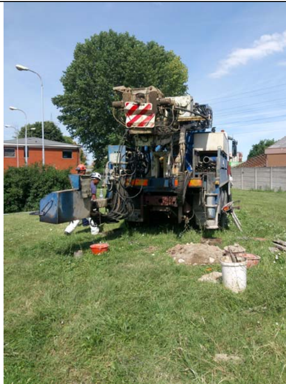
Postazione Sondaggio S03
