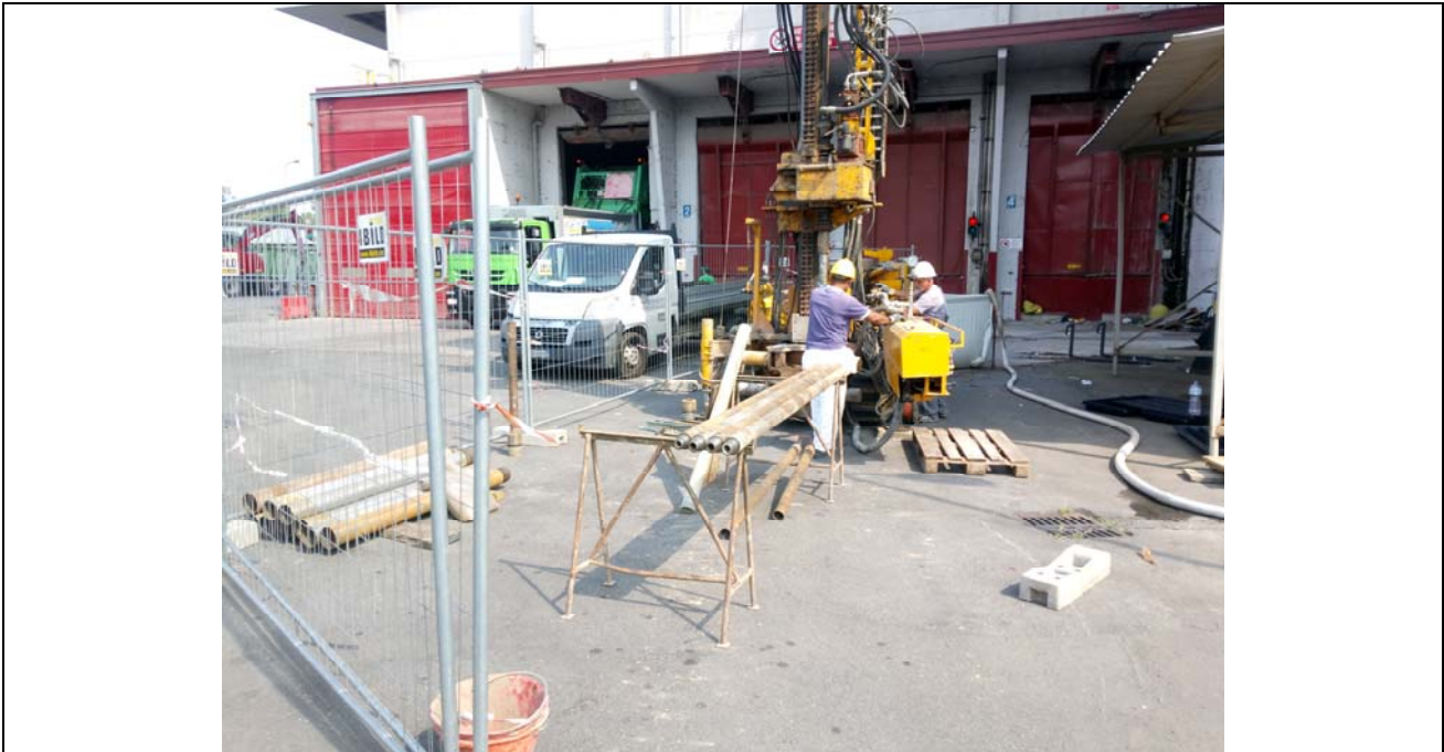
Postazione Sondaggio S01
